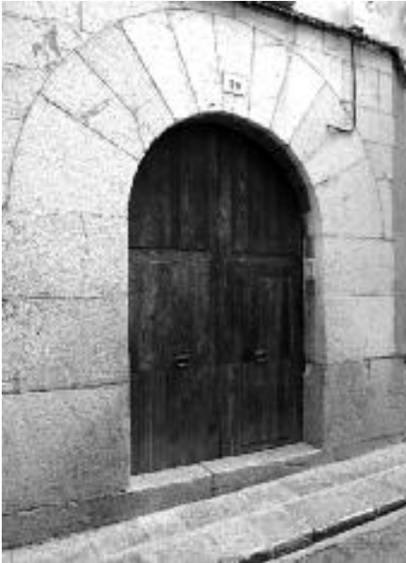
Arc rodó amb dovelles simulades al coixí del carrer Victòria 10 (Sóller).
