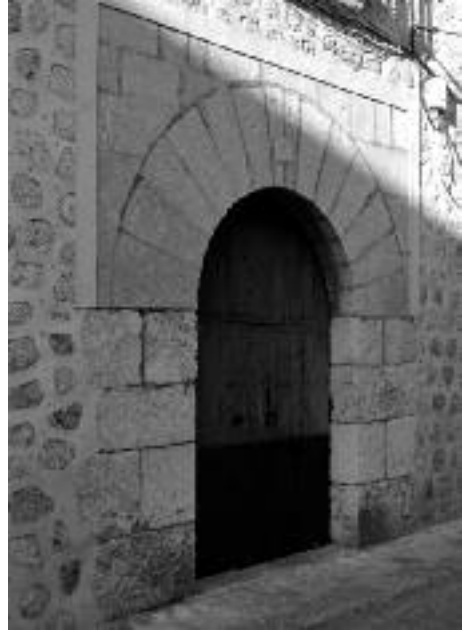
Portal de dovelles pars de la posada de Bàlitz (Sóller).
