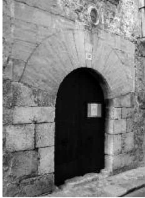
Portal del carrer de la Mar, nº 13 (Sóller) (Can Mo) (Pérez, 1998: 65), amb el coixí o dovella d'arrencada de calcita juràssica i les dovelles de marès.
