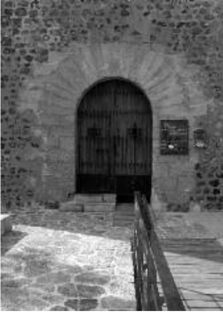
Portal de Santa Caterina (entre 1543-1550).
