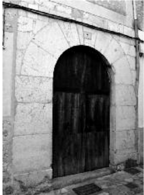
Portal de dovelles irregulars del carrer Rosa, nº 7.
