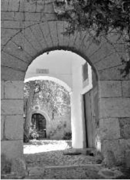
Portal de Binibassí, amb composició decreixent en la gruixa de les dovelles.
