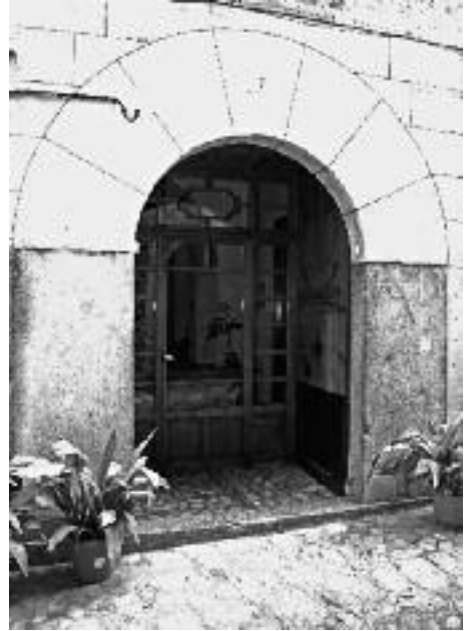
Portal de brancals d'una peça, amb 13 dovelles de marès falsejades i arrebossades simulant 7 dovelles.
