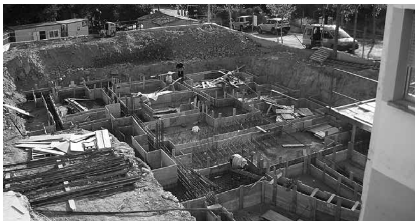
Fonaments de l'ampliació per a Infantil del Puig realitzats el 2011, obres en-vestides paral·lelament amb el nou edifici del Fossaret i l'ampliació de l'Institut.
