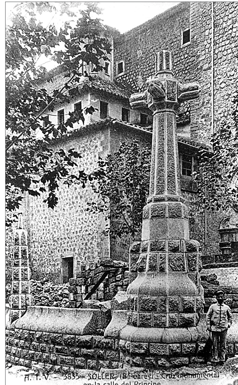
Tanca de pedra i creu helioidal en construcció
