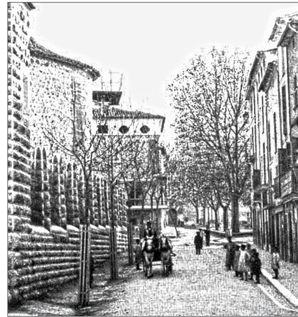
Primera fase de les obres de la tanca del Born vista des de Plaça
