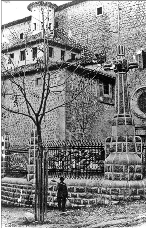
Tanca de pedra i creu helicoidal construïdes
