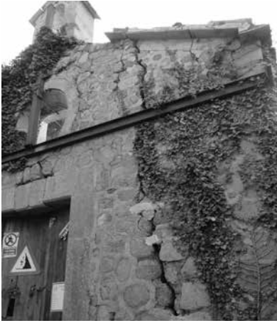
Un anell de ferro subjecta l'estructura.
